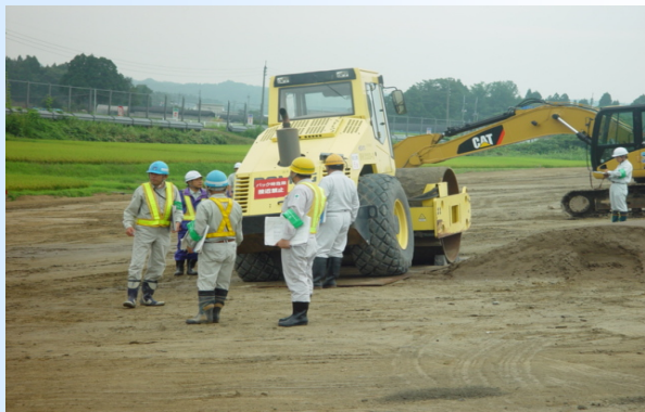
現場パトロールの様子
