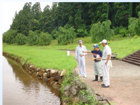
親水公園の点検の様子
