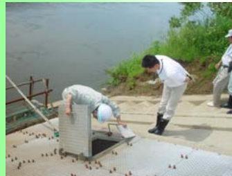
大野揚水機場の点検の様子
