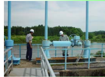
強首揚水機場の点検の様子
