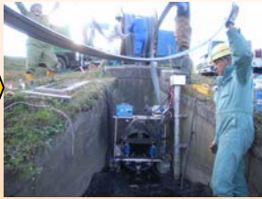
材料巻立状況
