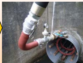
モルタル注入状況
