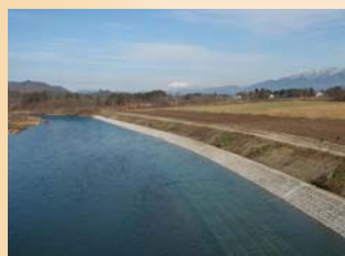
玉川 長戸呂護岸工事【着工後】
