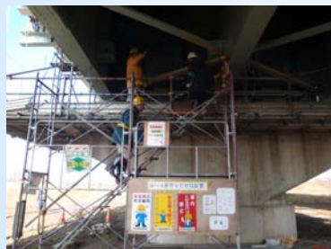
現場パトロールの様子
