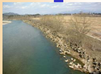
玉川 長戸呂護岸工事【着工前】
