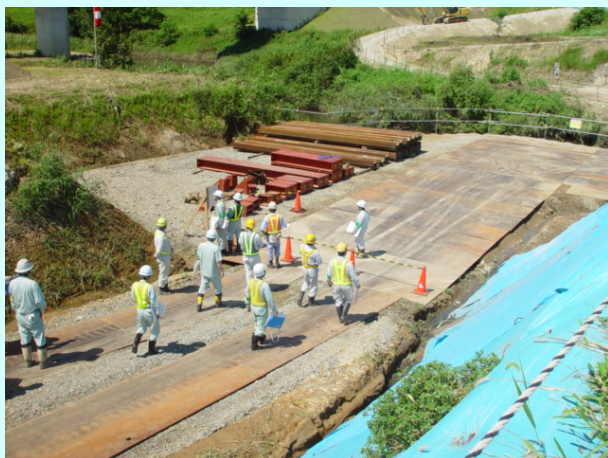
↑現場パトロールの様子
