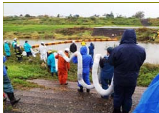
河川へのオイルフェンス設置
