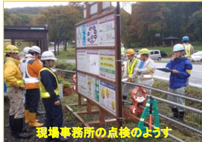
砂防堰堤工事の現場をパトロール
