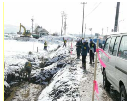
道路改良舗装工事の現場をパトロール
