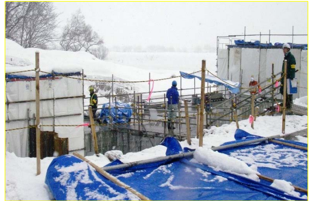
樋門新設工事(河川)の現場をパトロール
