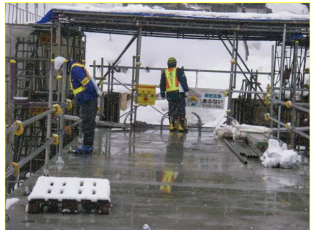
樋門工事のための、足場箇所を点検
