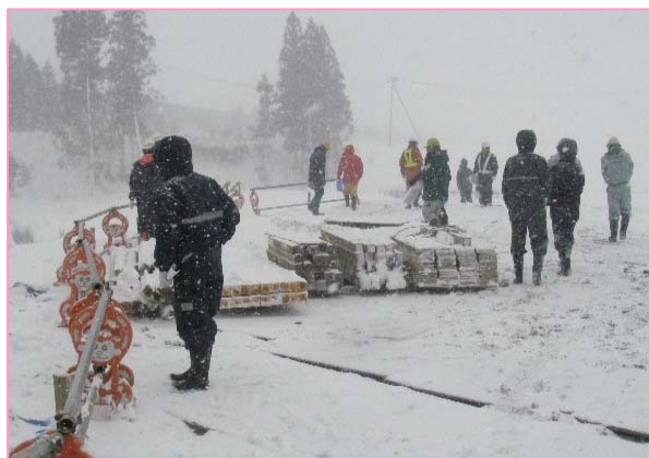
【樋門新設工事の現場を点検】
