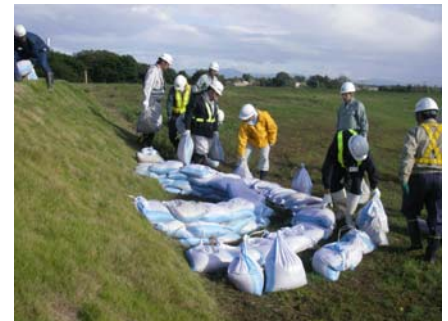
水防工法の演習(月の輪工法)
