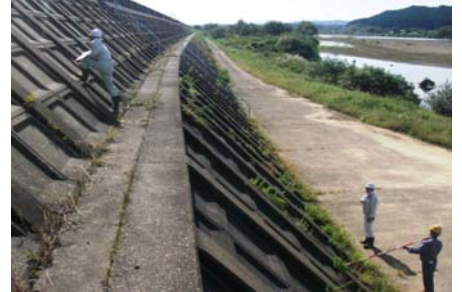
専用の工具を堤防へ貫入し空洞化がないか調査
