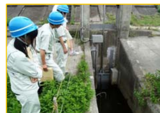
「樋管」のゲート操作を見て、洪水時の役割を学習。
