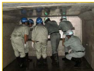
完成前の樋門の函体内に入り見学。
