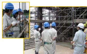
樋門の鉄筋組み立て体験
