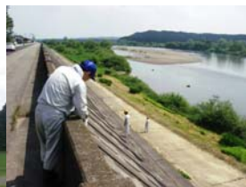
堤防の上を見る人、 下側を見る人などに 分かれ、堤防全体を 確認しながら点検。
