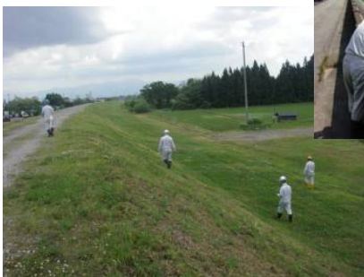
堤防の上を見る人、 下側を見る人などに 分かれ、堤防全体を 確認しながら点検。
