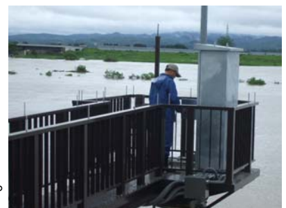
増水による操作員のゲート操作
