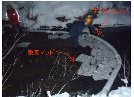
吸着マットを設置している様子
