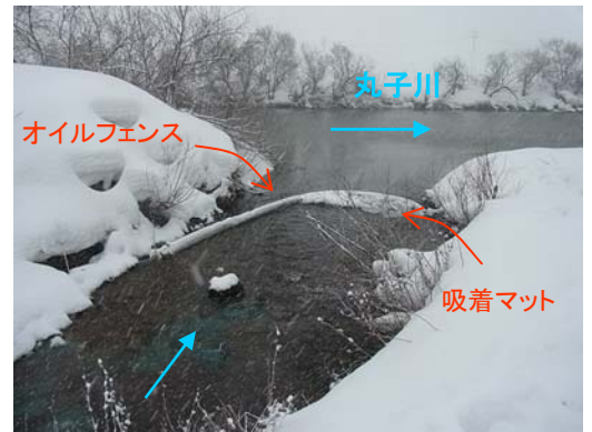
丸子川への流出を防ぐためのオイルフェンス設置後の様子
