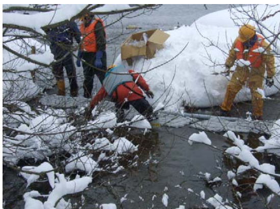
オイルフェンス、吸着マットを設置している様子
