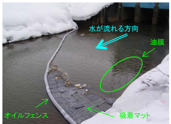
オイルフェンス設置後
