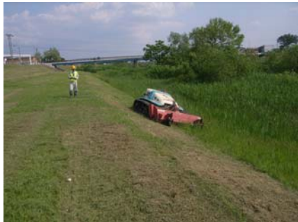
ラジコン式草刈機による作業
