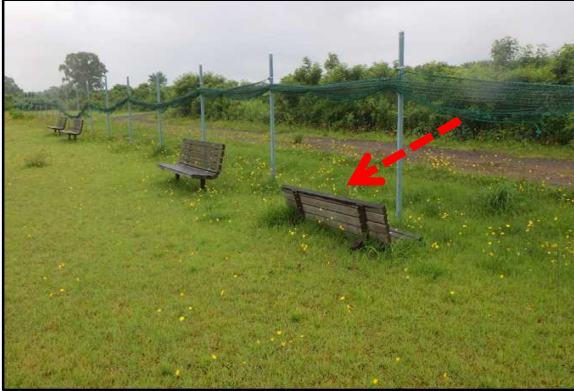
●ベンチの破損
