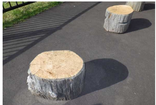
○劣化した椅子を撤去し、他の椅子は表面を磨きました。
