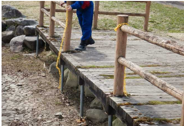
転落防止用チェーンの破損 GW前までに補修します。
