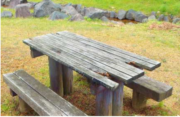
テーブルの損傷
