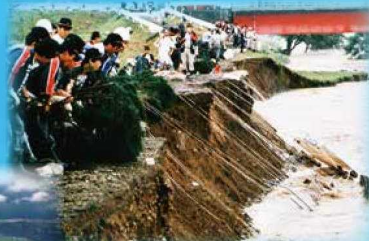
1987年(昭和62年) 河岸崩壊を抑える水防活動 (写真は横手市増田 成瀬川)
