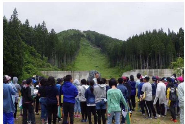
供養佛沢砂防堰堤
