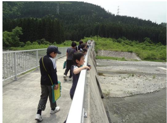
生保内川遊砂地(大暗渠砂防堰堤)
