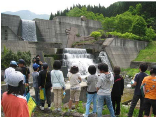
小先達川第1砂防堰堤
