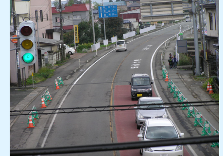
▼バイパス区間全線開通1年後の現国道13号
