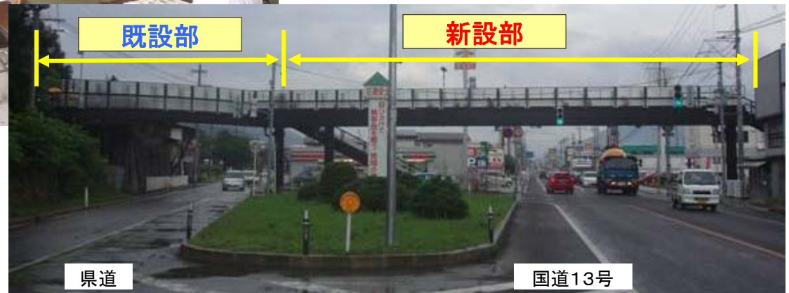
連結した横断歩道橋
