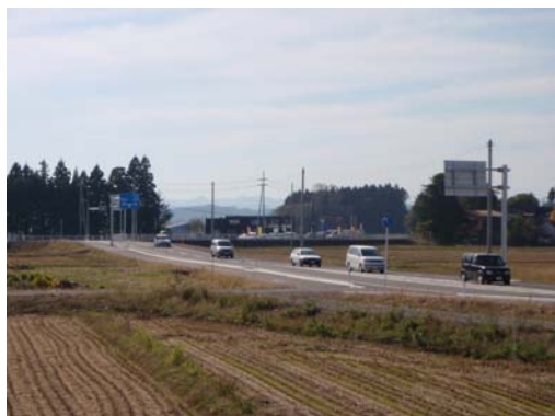
☆ 国道13号からバイパスつながる市道大坪線 ☆
