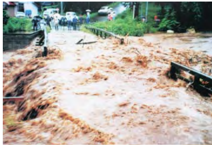
決壊し流失してしまった蓬莢橋 (羽後町上石地藏地先)
