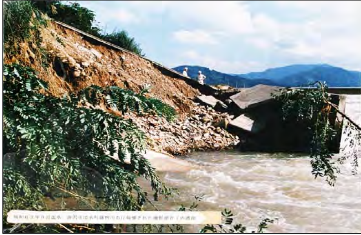
破壊された幡野頭首工の護岸 (湯沢市清水町雄物川右岸)
