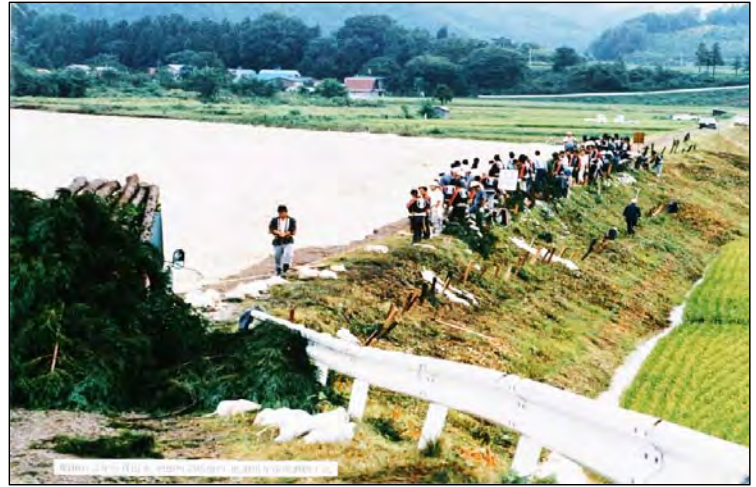
水防活動（増田町羽場地内成瀬橋上流）
