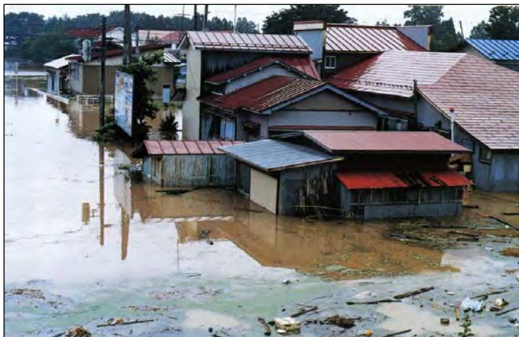
国道13号付近の浸水（西仙北町刈和野地先）
