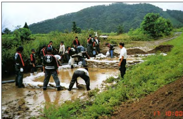
堤防漏水のため月の輪工を実施する水防団 (旧中仙鑓見内地先)
