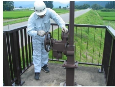
施設点検(樋門ゲート設備)の状況
