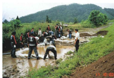
漏水被害の状況 (秋田県大仙市鍵見内地先)
