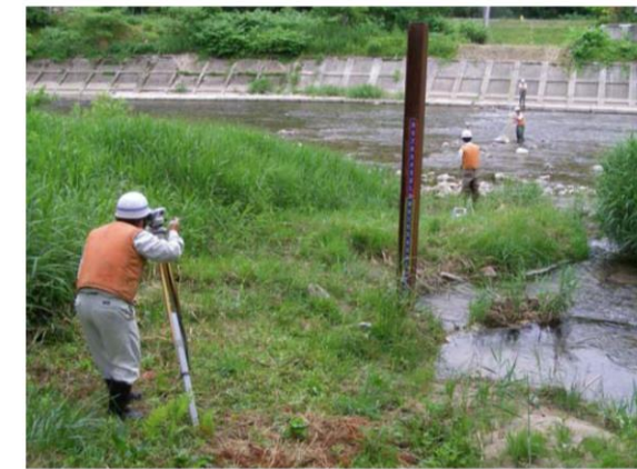
河川横断測量の様子
