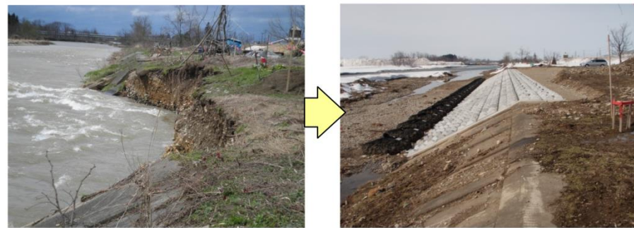
護岸の損傷
