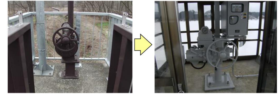
ゲート開閉装置の更新 (手動→電動)
