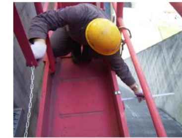
放流設備点検状況
