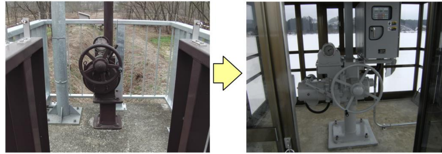
ゲート開閉装置の更新 (手動→電動)
