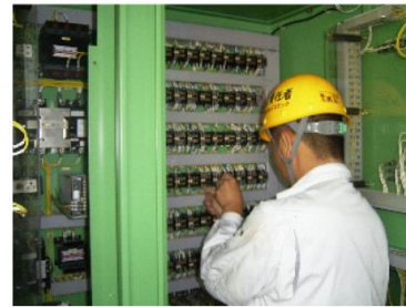
機側操作盤の点検状況
