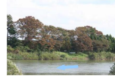
きょうゆうおおほし 協雄大橋付近の樹木の繁茂状況
