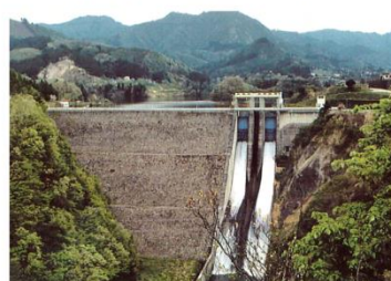
皆瀬ダム (昭和 38 年完成)
