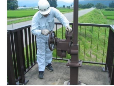
施設点検(樋門ゲート設備)の状況
