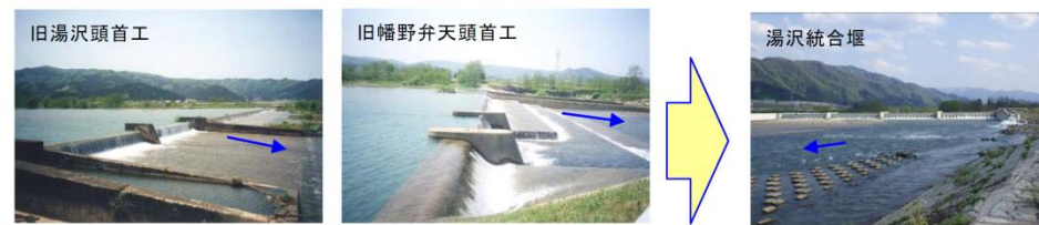
湯沢頭首工改修前後の施設状況
