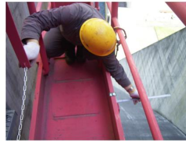
放流設備点検状況
