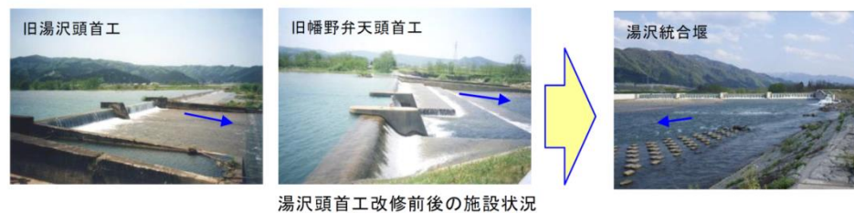
湯沢頭首工改修前後の施設状況
