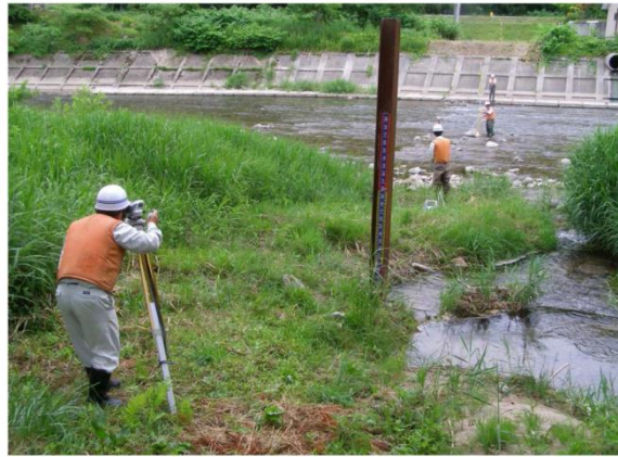
河川横断測量の様子
