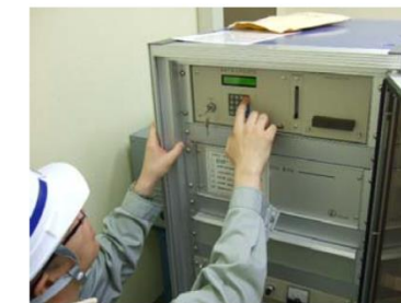
観測施設の点検状況
