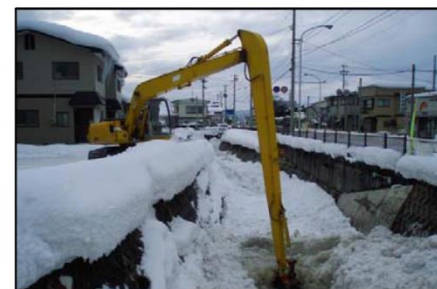
雪により閉塞した河川の復旧作業状況
