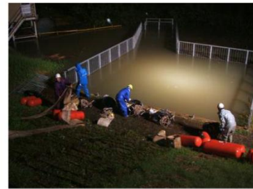
浜町排水ピット
