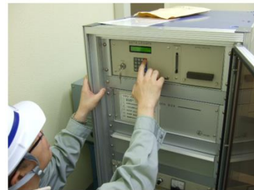
観測施設の点検状況
