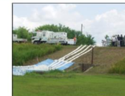
排水ポンプ車訓練状況 (大仙市 福部内川)
