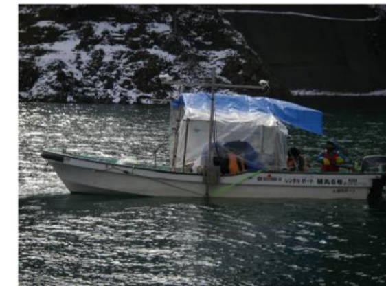
ダムの堆砂測量の様子
