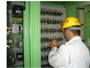
機側操作盤の点検状況
