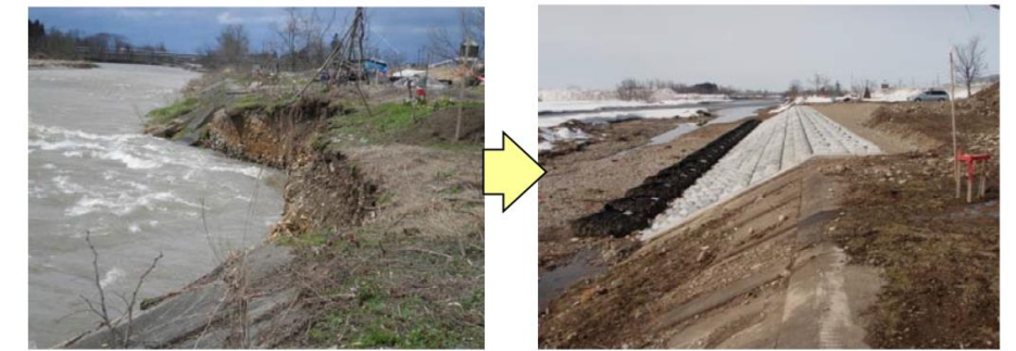
護岸の損傷
