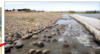
粗石付き斜路式魚道
