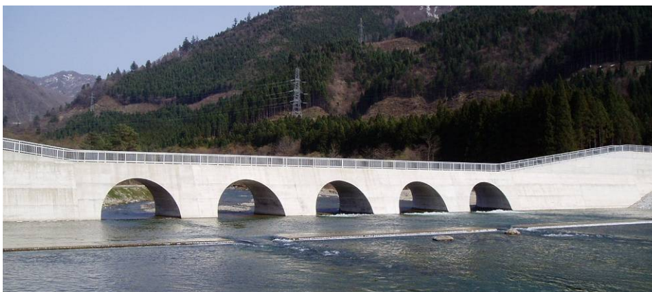
大暗渠砂防堰堤(平成18年2月完成)
