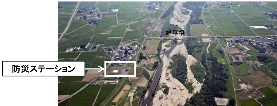
21 十文字防災ステーション（皆瀬川右岸：横手市）
