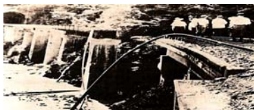
田沢湖線被害状況（昭和35年）
