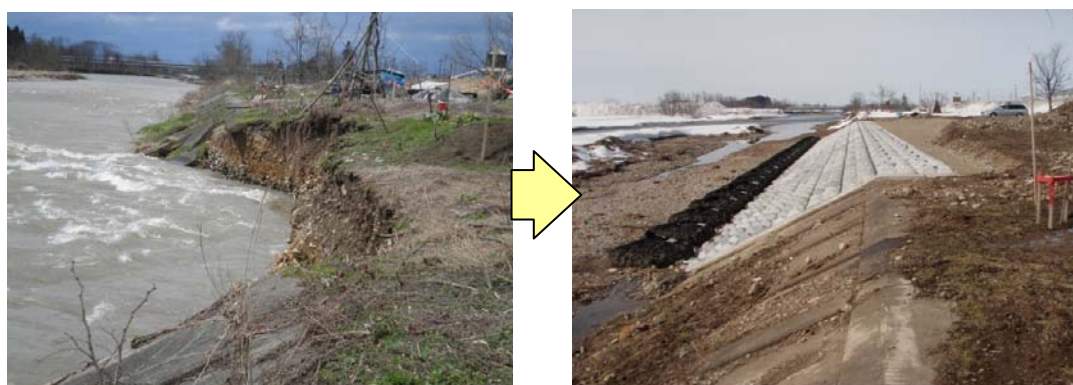
護岸の損傷
