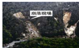
先達川被害状況（平成9年）
