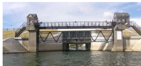
新屋水門（改築後）
