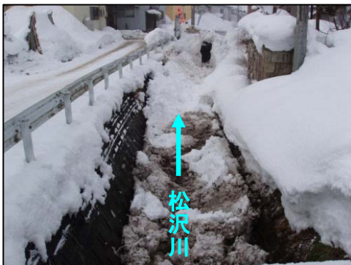
消流雪用水の通水実施状況（松沢川）
