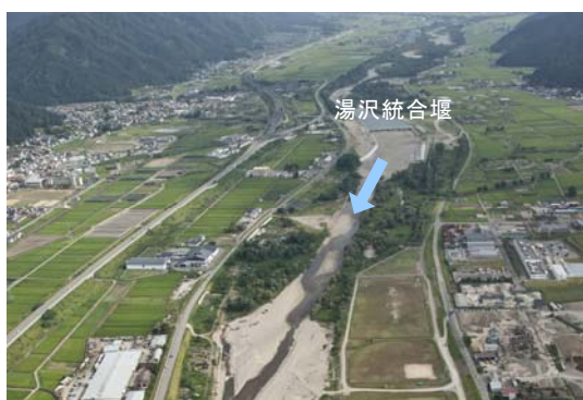
雄物川上流部の砂州の状況
