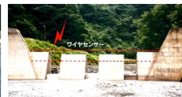
土砂移動検知センサー
