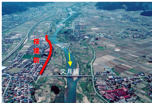
20 文月橋上流の桜堤防区間
