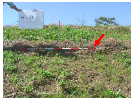
洪水痕跡調査の状況
