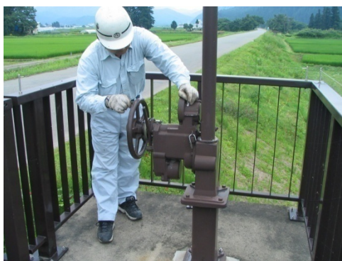
施設点検（樋門ゲート設備）の状況
