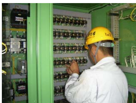
機側操作盤の点検状況
