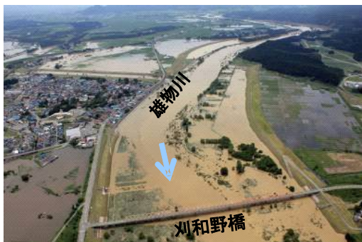
平成 23 年 6 月洪水写真 (刈和野橋地点)
