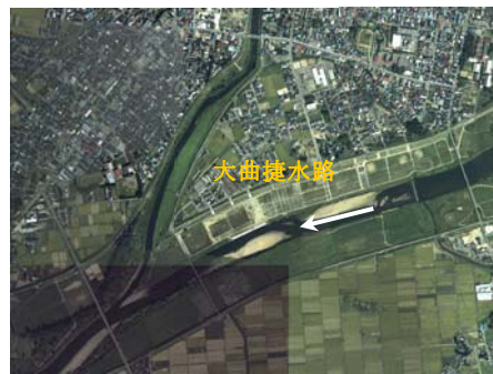
大曲捷水路完成後（平成22年）
