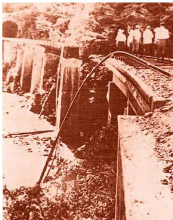
17 昭和35年の土砂災害（JR田沢湖線被害状況）
