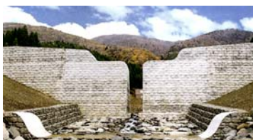
黒沢第1砂防堰堤
