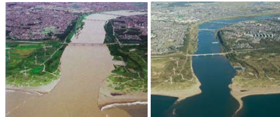
洪水時 (H19. 9. 18) 洪水後 (H19. 10. 18) 河口の状況
