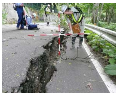
TEC-FORCE の派遣状況 岩手県沿岸北部地震 (平成20年7月24日)
