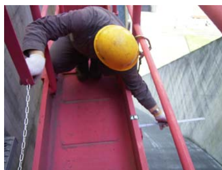
放流設備点検状況
