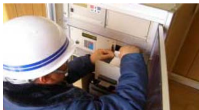
観測所保守点検状況
