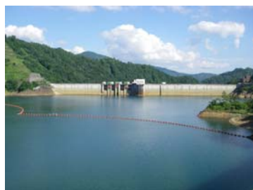
玉川ダム 流木止施設
