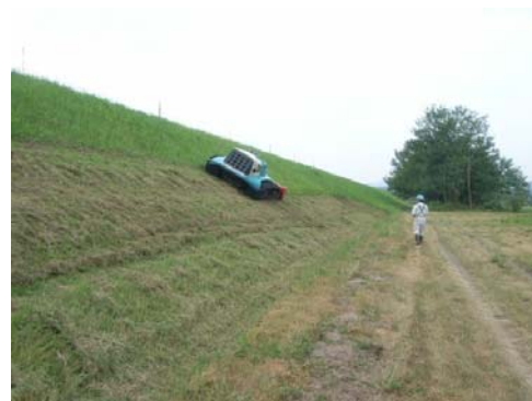
21 堤防除草作業状況
