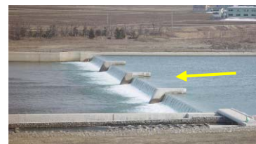
大久保堰（改築後）
