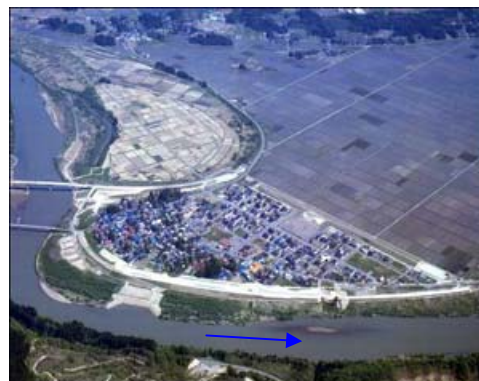
強首輪中堤（完成後）
