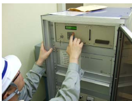
観測施設の点検状況
