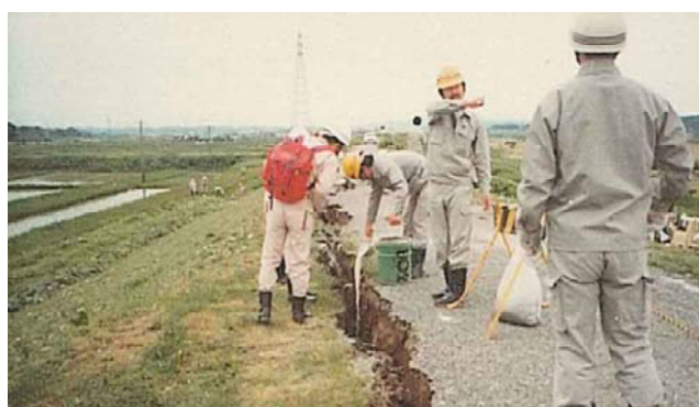
19 日本海中部地震で発生した堤防の亀裂に 20 石灰水を注入することにより亀裂深を調査（秋田市牛島地区） 21 22
