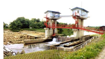
大久保頭首工（改築前）
