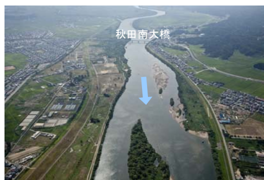
雄物川下流部の砂州の状況
