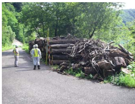
流木処理の状況
