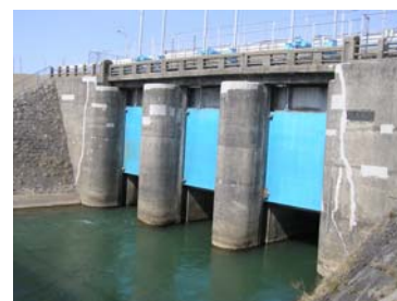
新屋水門（改築前）
