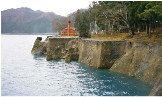
水位の低下により悪化した景観
