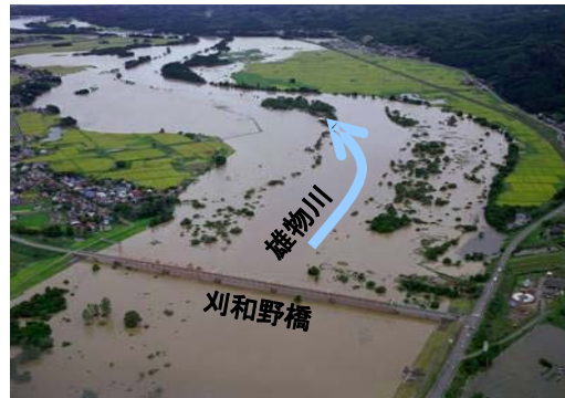
平成 19 年 9 月洪水写真 (刈和野橋地点)
