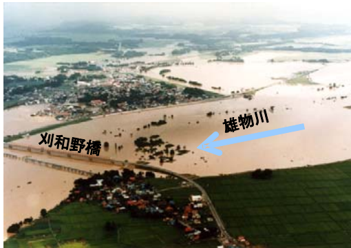
昭和 62 年 8 月洪水写真 (刈和野橋地点)
