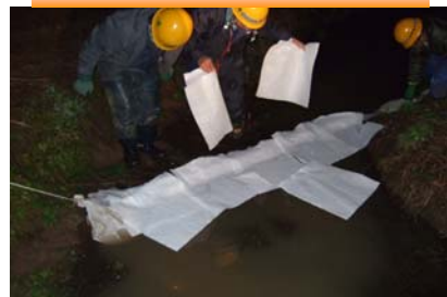
油の除去作業をしている様子
