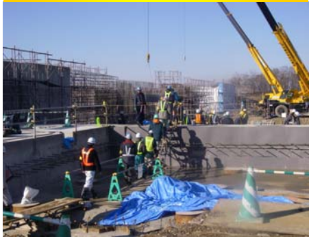
湯沢統合堰改築工事現場のパトロールの様子
