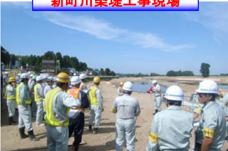
新町川築堤工事現場
