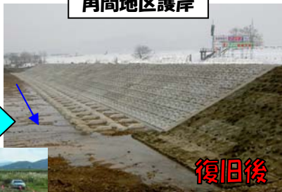
角間地区護岸
