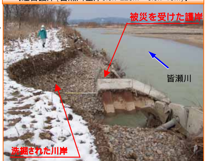
【睦合護岸(皆瀬川左岸0.0k-220m~0.0k-10m)】
