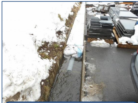
② オイル吸着マット設置設置状況
