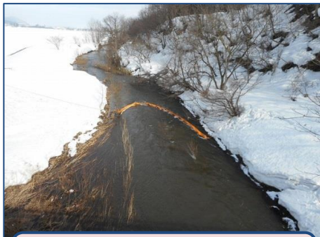
① オイルフェンス設置設置状況
