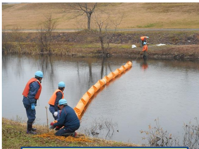
オイルフェンスを設置している様子
