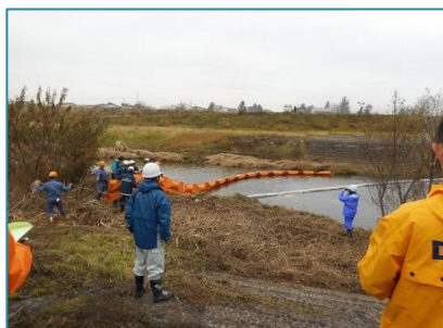
オイルフェンス設置の様子
