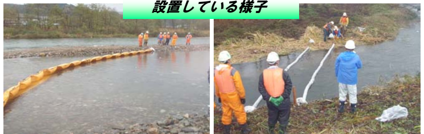
オイルフェンスを 設置している様子
