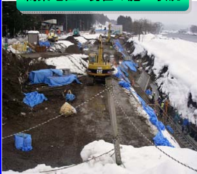
鶴巢地区 現在の施工状況
