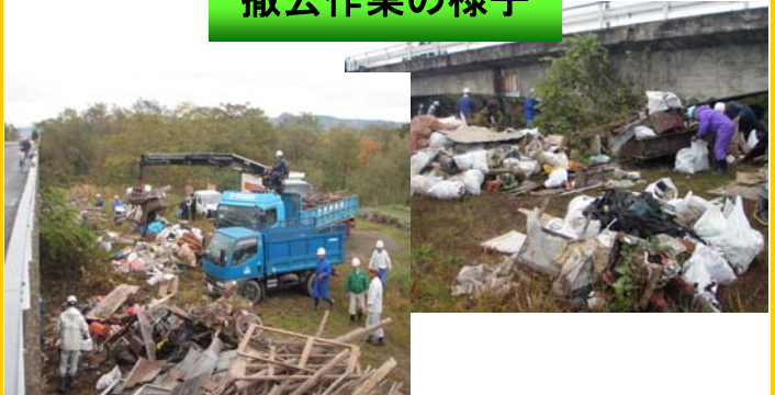
撤去作業の様子
