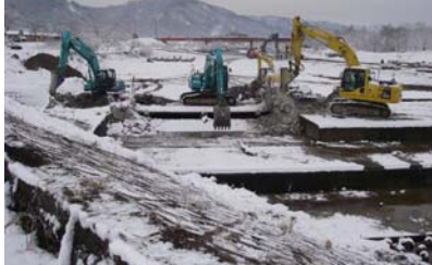
幡野弁天堰 堰本体取り壊し状況
