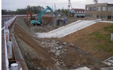
湯沢統合堰 旧取水樋門取り壊し状況
