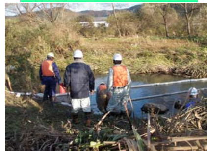
実際にオイルフェンスを設置している様子
