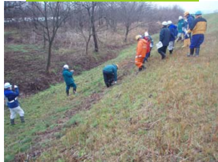
堤防の芝の状態を調査している様子
