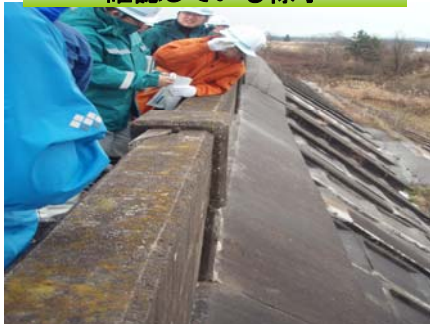
コンクリートの亀裂などを確認している様子
