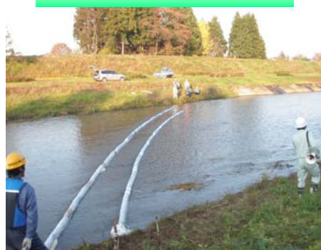
実際にオイルフェンスを 設置している様子
