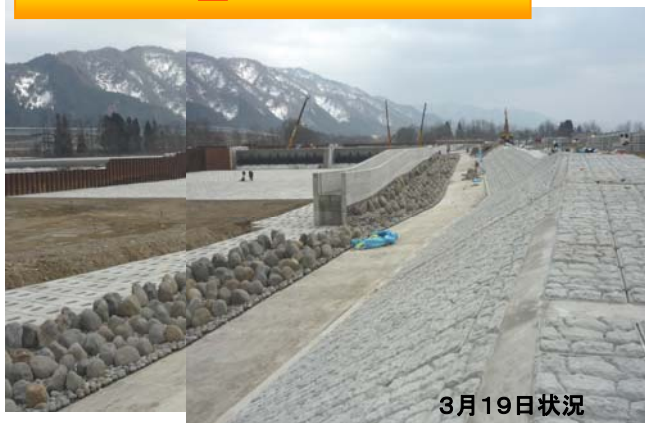
湯沢統合堰__左岸側通水前の様子
