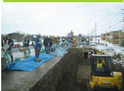
湯沢沼樋地区導水路工事現場の パトロールの様子
