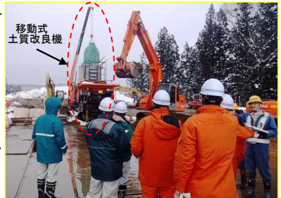
築堤用の土の土質改良を見学する様子
