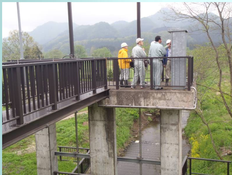
ゲートの操作を確認しています
