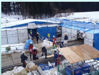
現場パトロールの様子(樋門新設工事)
