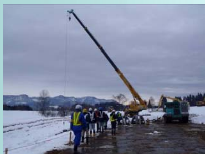
現場パトロールの様子(築堤護岸工事)
