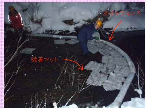
吸着マットを設置している様子
