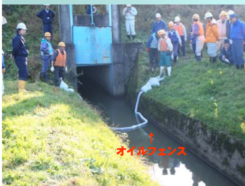
狭い水路へ取り付けている様子
